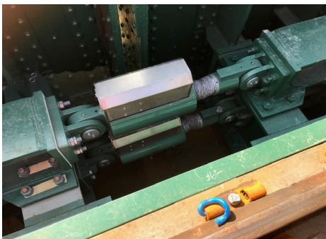
ISOSISM® STU su viadotto ferroviario: Don Viaduct (UK)
