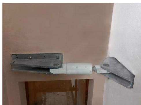
ISOSISM® FD installato in un edificio esistente
