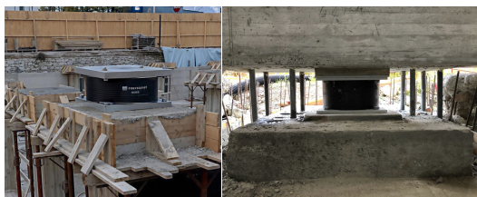
ISOSISM® LRB - installazione – Esempio di struttura nuova ed esistente
