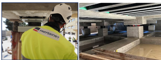
ISOSISM® HDRB – Installazione eseguita da Freyssinet – esempi di struttura nuova ed esistente
